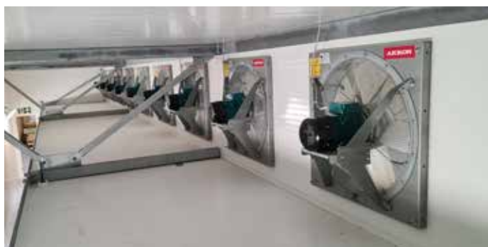
AG tørkeanlegg har god luftsirkulasjon som sikrer rask og jevn tørking.
