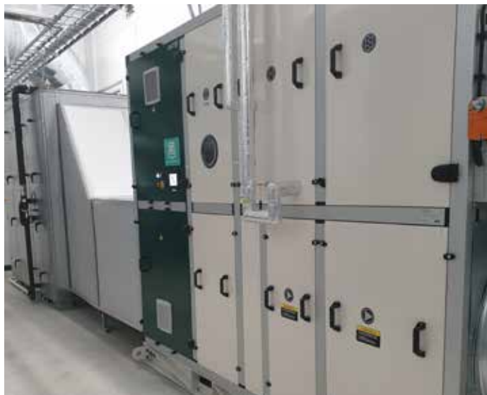
Typisk fordampner og avfukter-enhet for klippfisk
