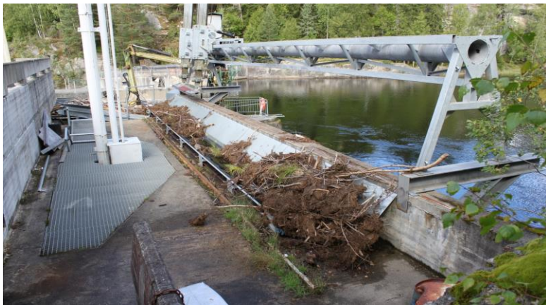
Elvekraftverk kan ha problemer store mengder med grove partikler som kvist, blader, barnåler og søppel. Bildet over viser innholdet fra tømningen av et gammelt filter som senere er erstattet med AG DDF Filterautomat.
