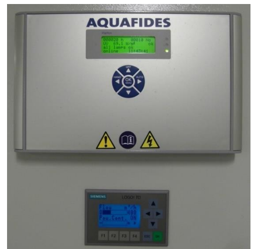
AQUAFIDES kontrollskap med effektregulering og display som skifter farge etter driftsstatus
