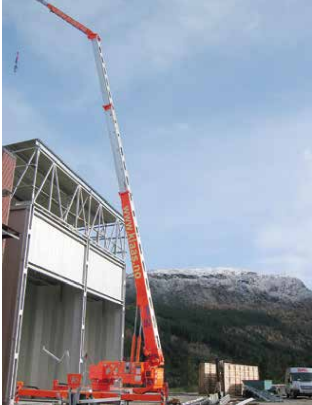
Alfsen og Gunderson har merket seg at mange sagbruk har ambisjoner om vekst. Her er det Eikås sagbruk som er i ferd med å fornye tørkeanlegget (Foto AG).
